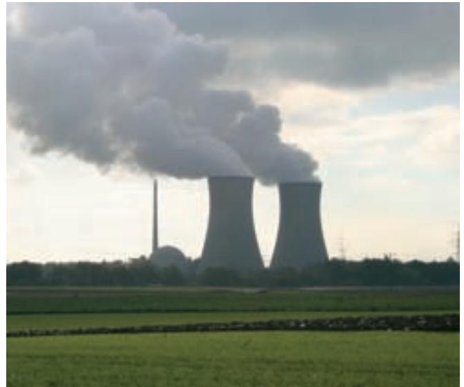
Kernkraftwerk Grafenrheinfeld (KKG)
